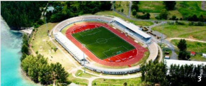
2. Vijay 是伊甸岛开发区中心伊甸广场的主要承包商，该广场有高端购物中心、超市、餐厅和保龄球馆。3. Vijay 在不短 13 个月的时间里，建造完成了国家体育场。2011 年印度洋运动会在此举行。图片：Vijay 建筑
