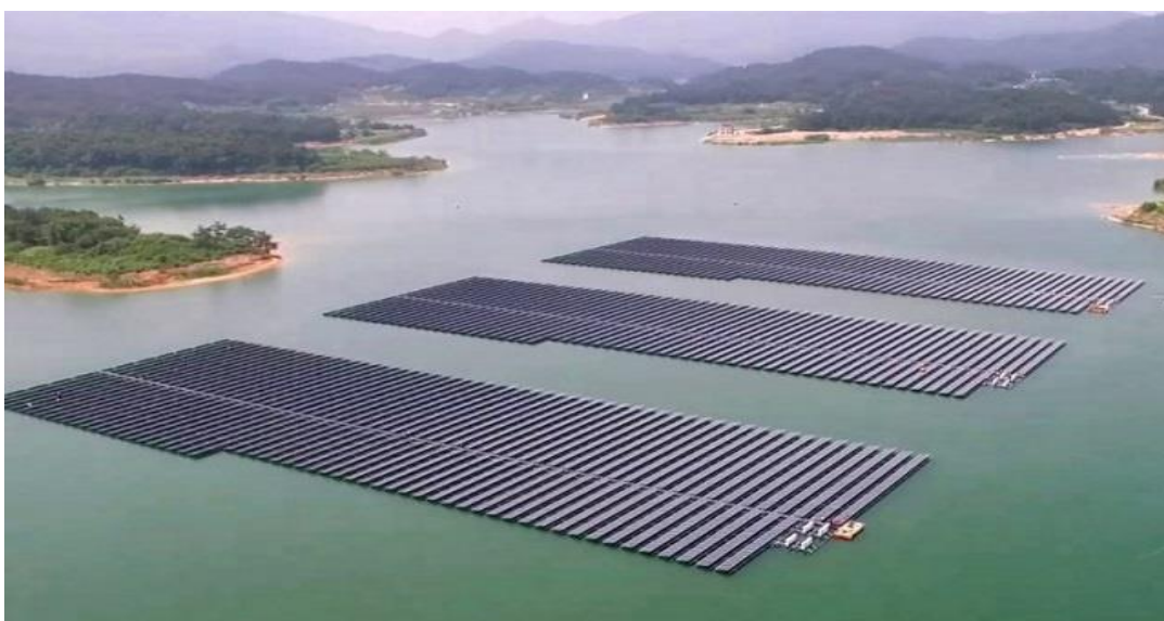
海上的光伏发电装置
